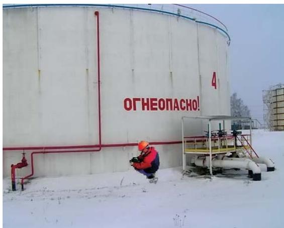
**рисунк 4.** Ультразвуковой контроль стенки резервуара без удаления антикоррозионного покрытия
