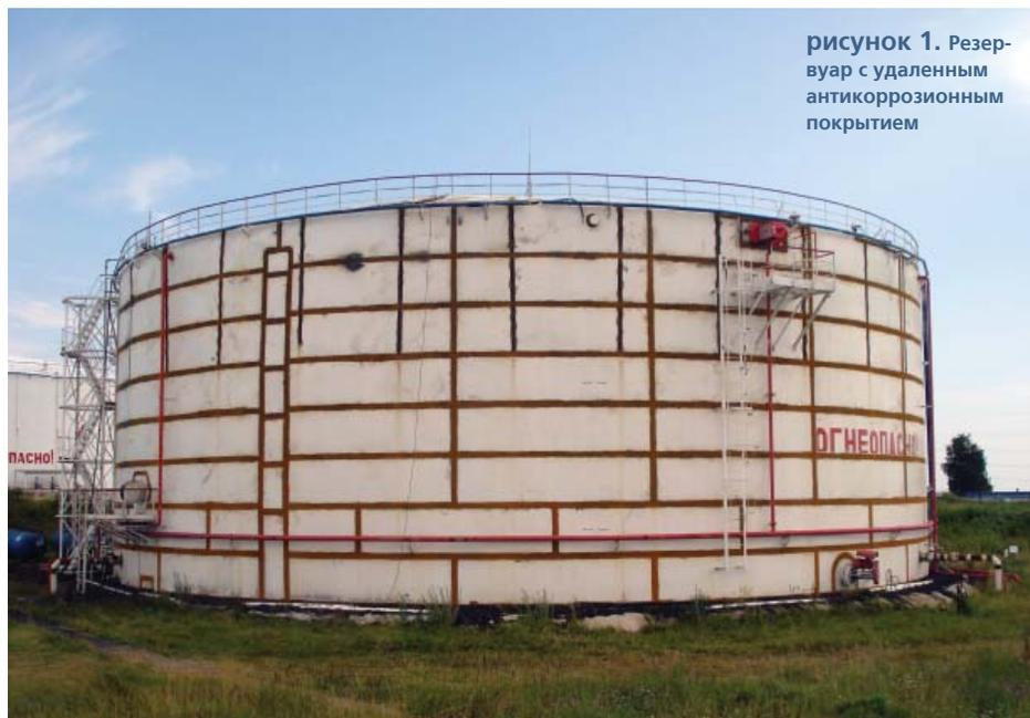
рисунок 1. Резервуар с удаленным антикоррозионным покрытием
